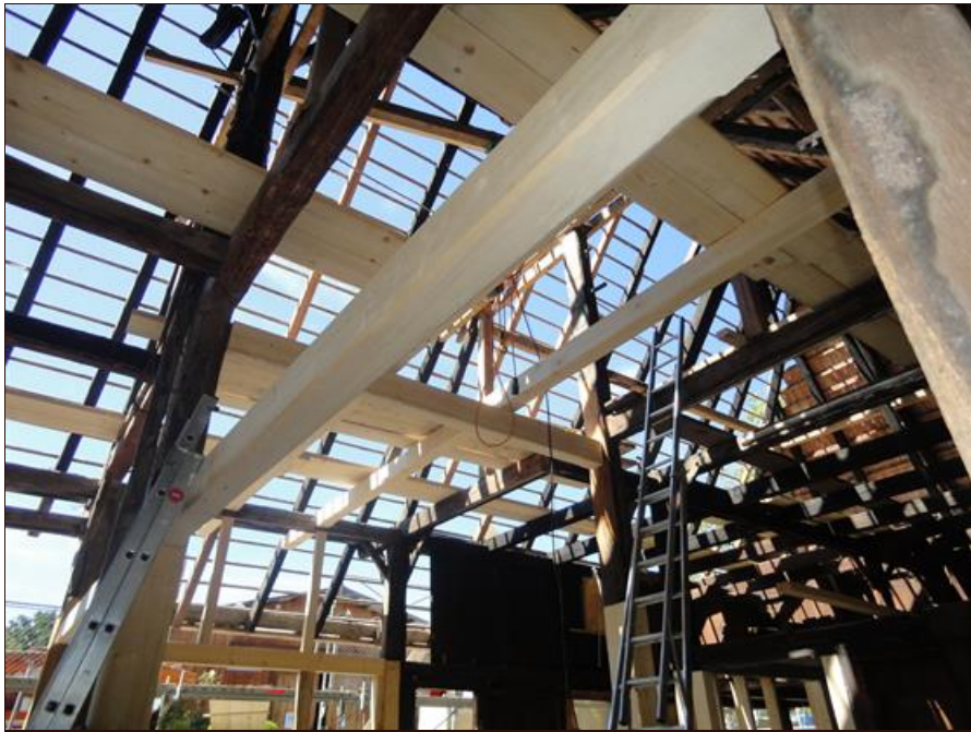
Dacharbeiten im Gange
