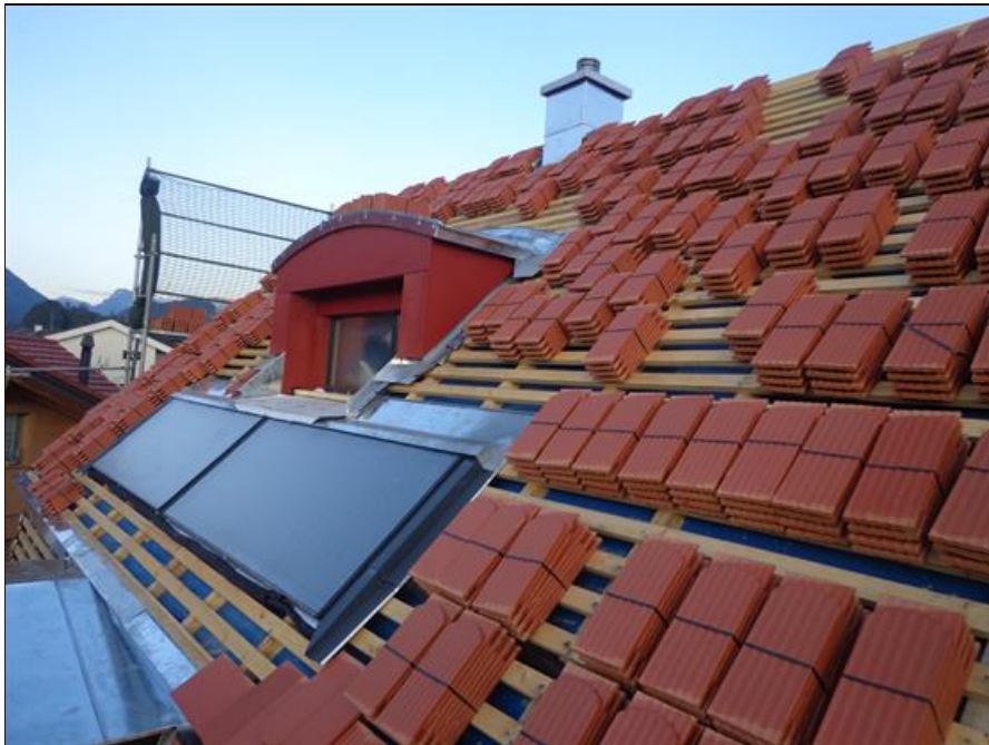
Lukarne, Solarpanels, Ziegel verteilt
