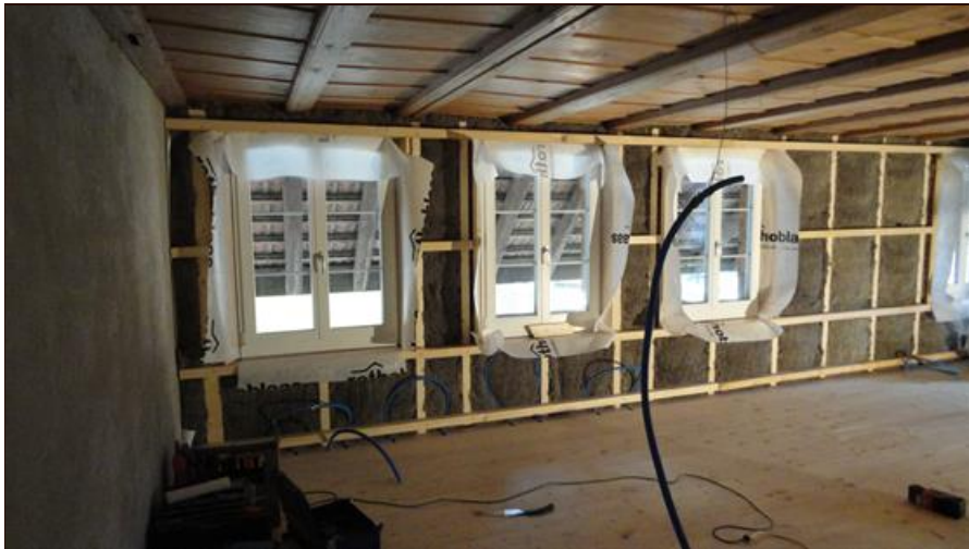
Gang Parkett fertig verlegt
