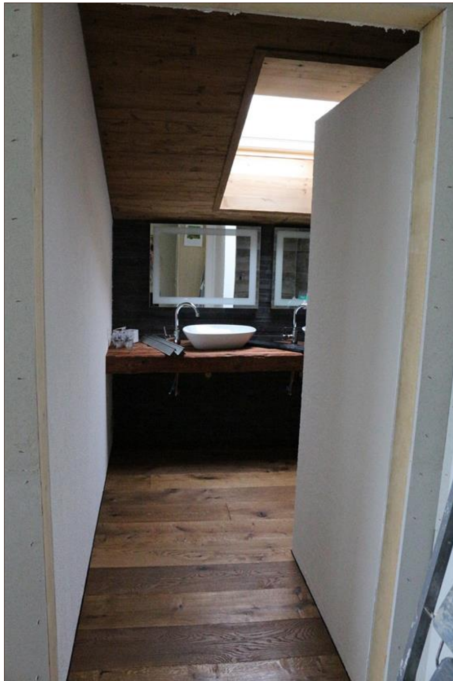
Balkenlage am säubern von alter Isolation
